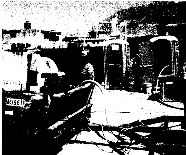
Foto 16: Instantes de realización del mantenimiento de los SS.HH., esto se realiza 02 veces por semana
