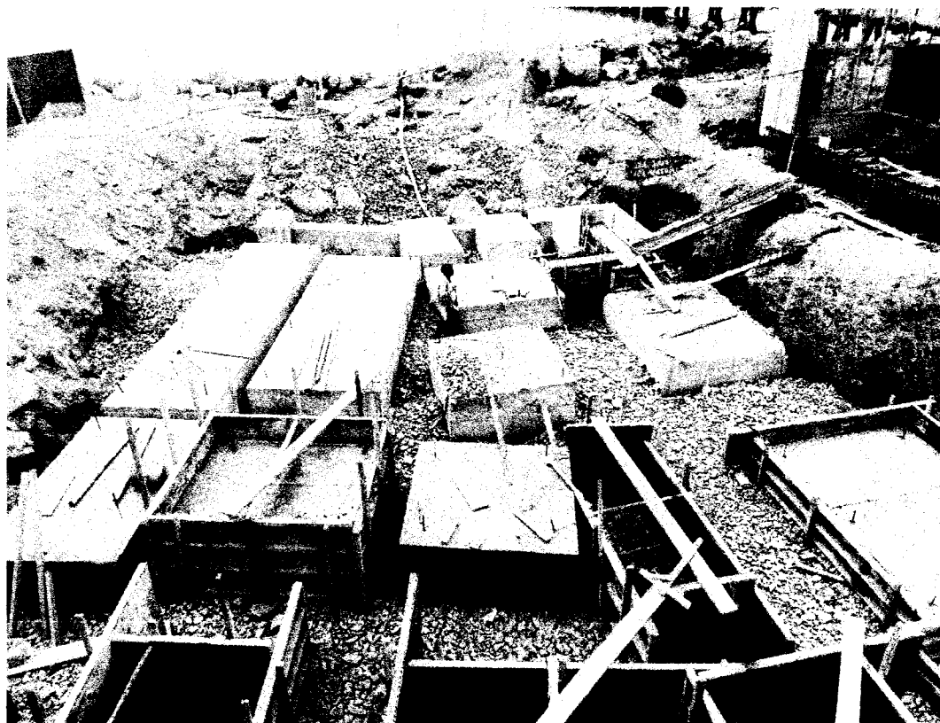
Foto N° 09: Vaciado de concreto en falso cimientó de Área de desinfección.
