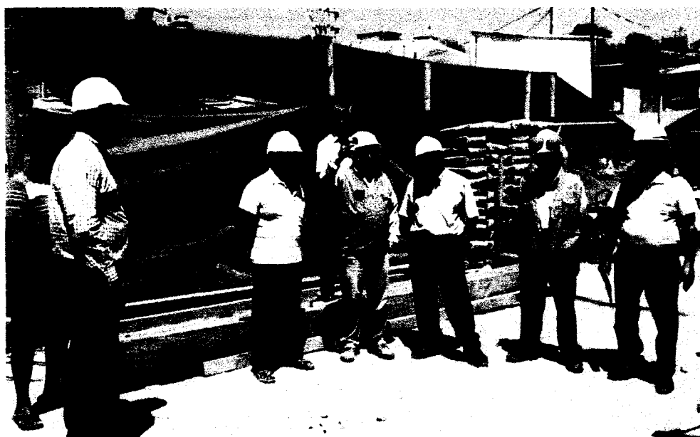
Foto 34: El ing. Supervisor de Obra Tang, explicando a los representantes de los pescadores sobre el avance de la obra
