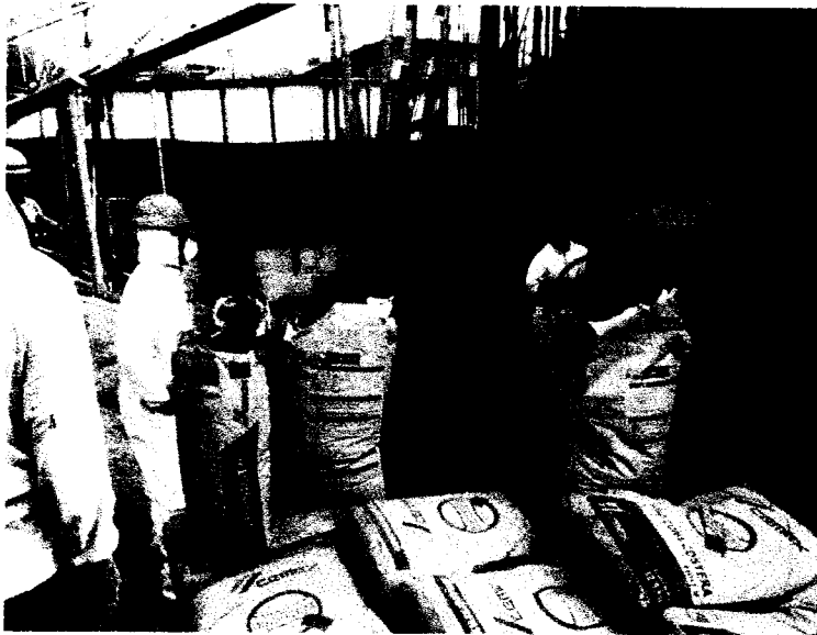
Foto 21: Para el caso de trabajos con cemento se verifica el uso del traje especial, así como guantes de jebe y el check list de la máquina
