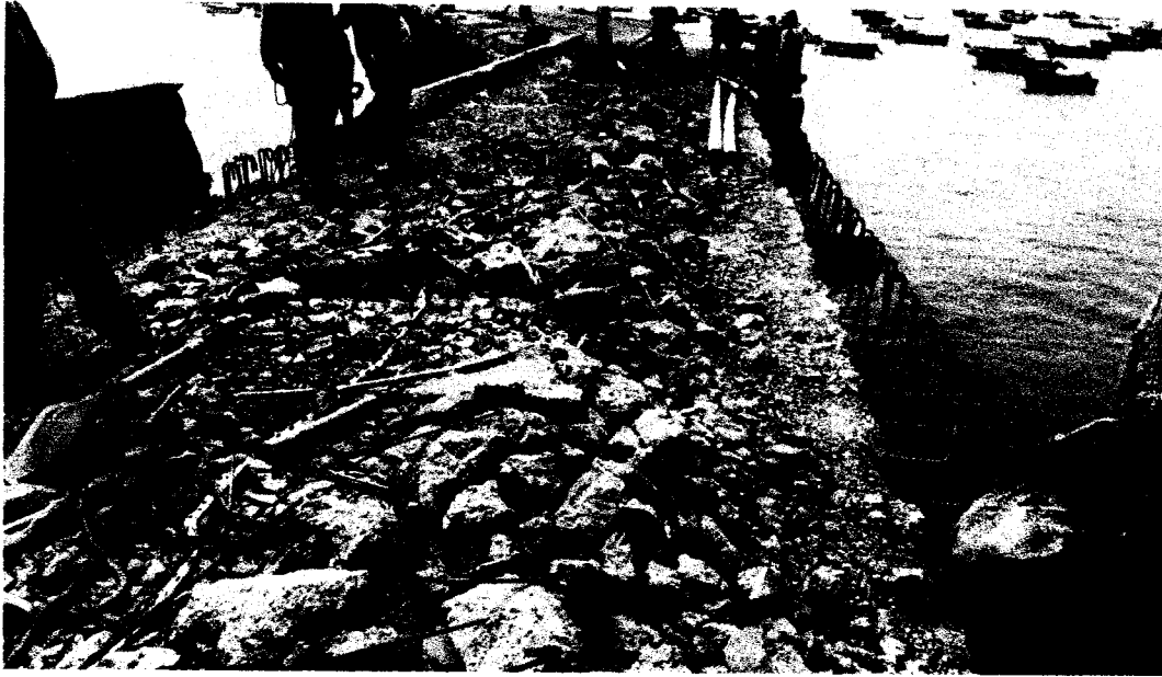
Foto N° 11: Demolición de viga de borde y picado de superficie de losa de puente de acceso en el muelle.
